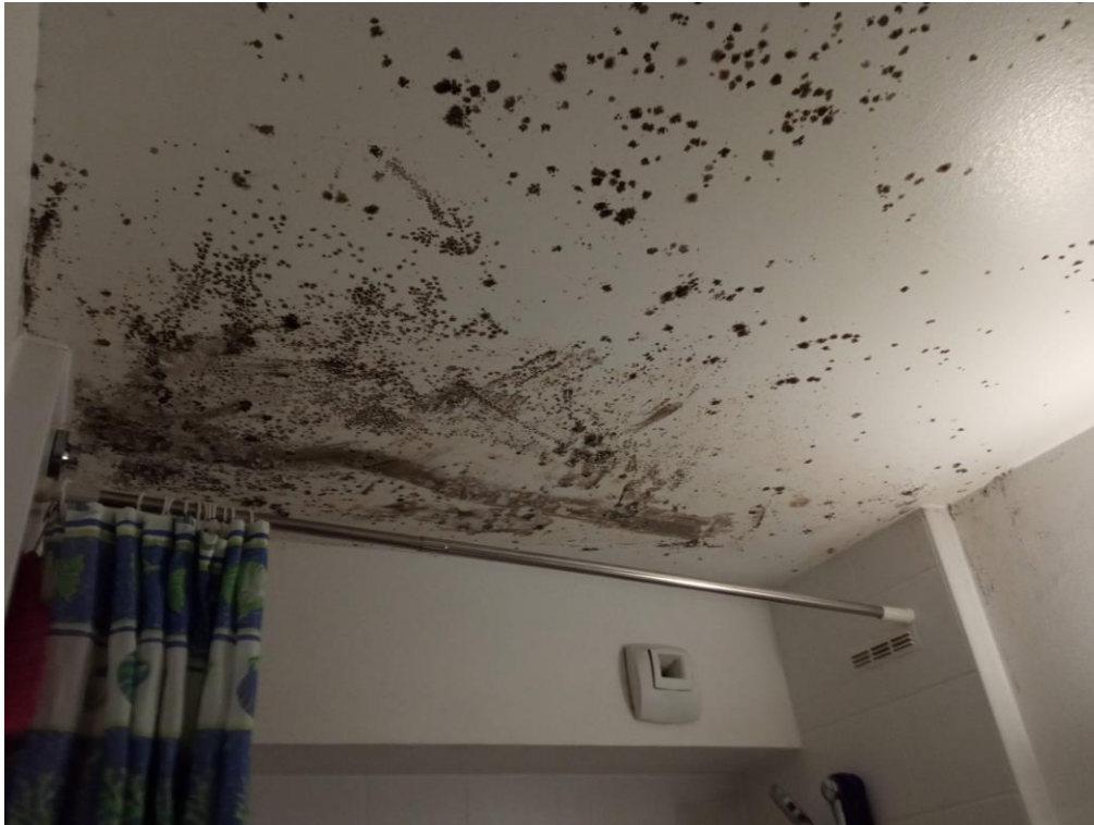
Défaut d'entretien extraction SDB / entrée d'air des fenêtres
