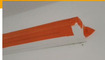
Défaut d'entretien extraction SDB / entrée d'air des fenêtres
