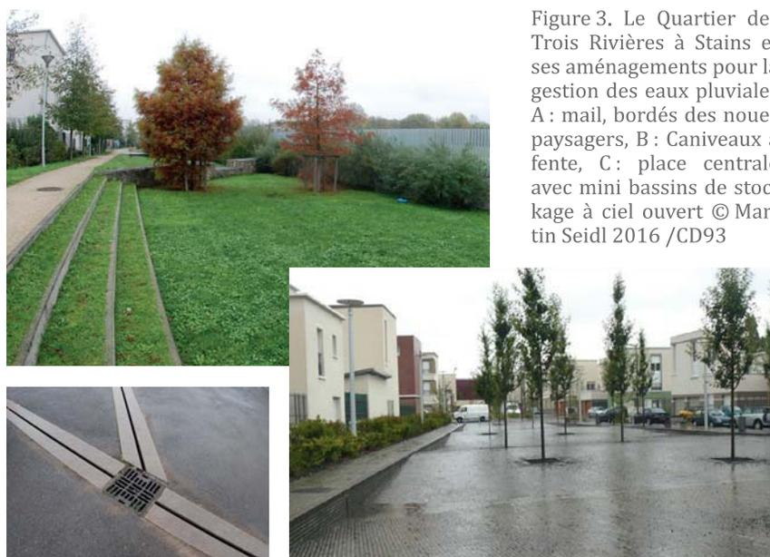
Figure 3. Le Quartier des Trois Rivières à Stains et ses aménagements pour la gestion des eaux pluviales A : mail, bordés des noues paysagers, B : Caniveaux à fente, C : place centrale avec mini bassins de stockage à ciel ouvert © Martin Seidl 2016 /CD93
